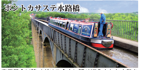
ポントカサステ水路橋 産業革命以降イギリス全土に張り巡らされた水路を今なお走るナローボート。高さ38m長さ307mの世界遺産の水路橋を渡ります。
