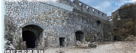
燐鉱石貯蔵庫跡
