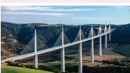
**世界一ミヨー高架橋** タルン川渓谷に架かる主塔の高さが343メートルと世界一高い道路専用の斜張橋です。
