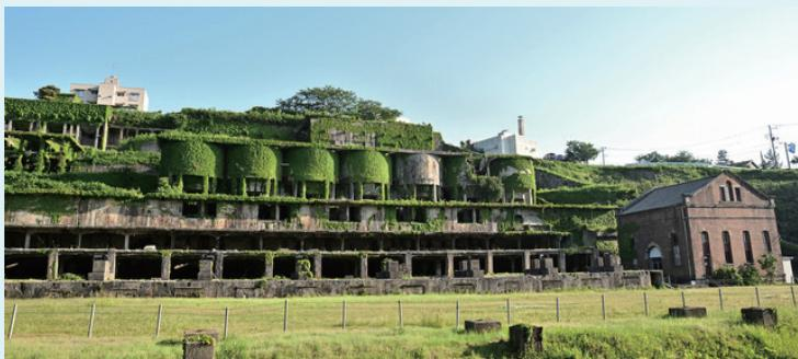
**北沢浮遊選鉱場** 銅の製造過程であった浮遊選鉱法を金銀の採取に応用し、日本で初めて実用化。戦時下に大規模な設備投資がされ、一ヶ月に五万トン以上の鉱石を処理した事から「東洋一」と謳われました。美しき近代産業遺産の一つです。
